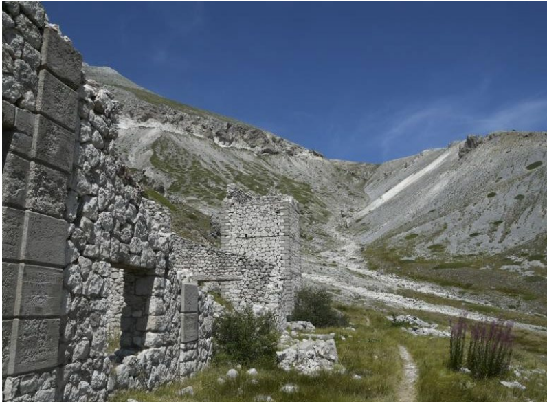
Fig. 7 – Ruederi della Miniera di Bitume. La torre in secondo piano era un forno a tino Manetta, dedicato alla lavorazione degli scisti bituminosi
